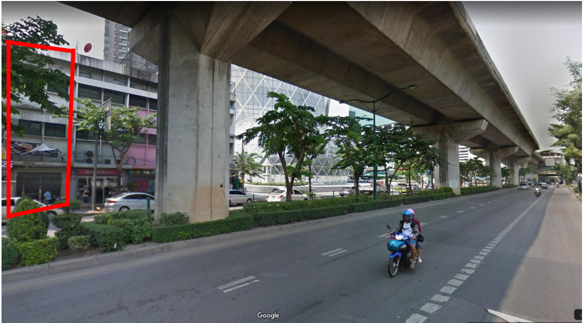
ภาพด้านหน้าอาคาร มองไปทางสถานีรถไฟฟ้าอารีย์
