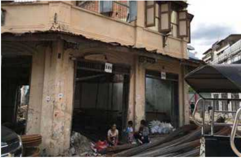
ตึกแถวชุมชนเลื่อนฤทธิ์ระหว่างการบูรณะ A shop house in Luean Rit community during restoration.
