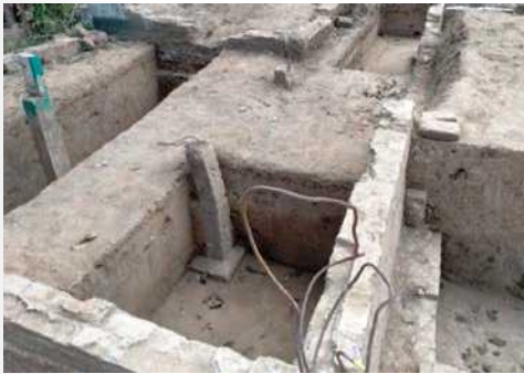
ฐานรากอาคาร Foundation of the house.
