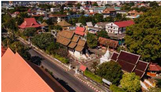
วัดปราสาท วัดที่มีวิหารต่อซุ้มจรนนำ รูปแบบวิหารที่แสดงถึงอัตลักษณ์อันโดดเด่นของพุทธศาสนาปัตยกรรมล้านนา Wat Prasat, the prototype of Lanna architecture with the porched vihara.
