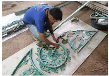
การประกอบชิ้นส่วนตกแต่งหน้าจั่วขึ้นจากเศษไม้เดิมที่ตุกรื้อถอน Reassembling the broken pieces of gable decoration.
