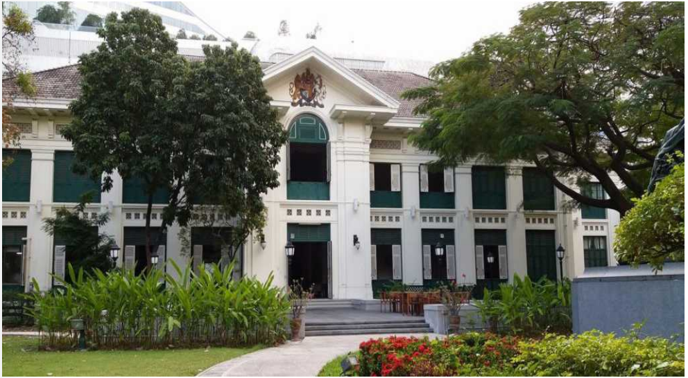
ສາທາລະນະສຳນັກງານກ່ອນຖືກຮົ່ວຄອນ The British Embassy before demolition.
