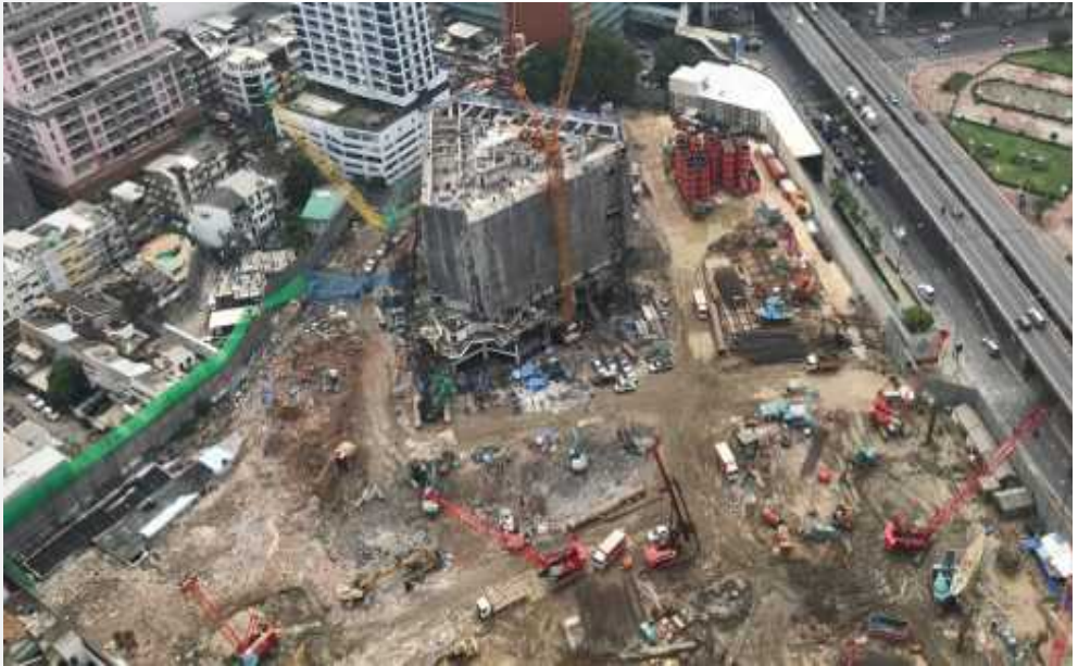
โรงแรมดุสิตธานีระหว่างการรื้อถอน Dusit Thani Hotel during demolition.
