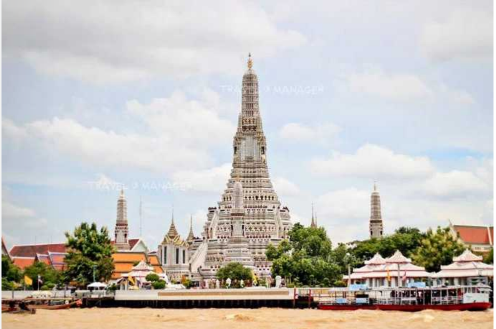
พระปรางค์วัดอรุณราชวราราม หลังการบูรณะ: สีดูขาวผ่องด้วยการทำความสะอาดและซ่อมแซมผิวปูน The Grand Stupa, Wat Arunratchawararam after restoration. The colour is white and clear by cleaning and surface repair.
