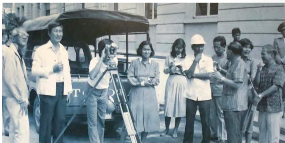
สมเด็จพระกนิษฐาธิราชเจ้า กรมสมเด็จพระเทพรัตนราชสุดาฯ สยามบรมราชกุมารี ทรงตรวจงานบูรณะ พระบรมมหาราชวัง HRH Princess Maha Chakri Sirindhorn during site visit to supervise the restoration of the Grand Palace.
