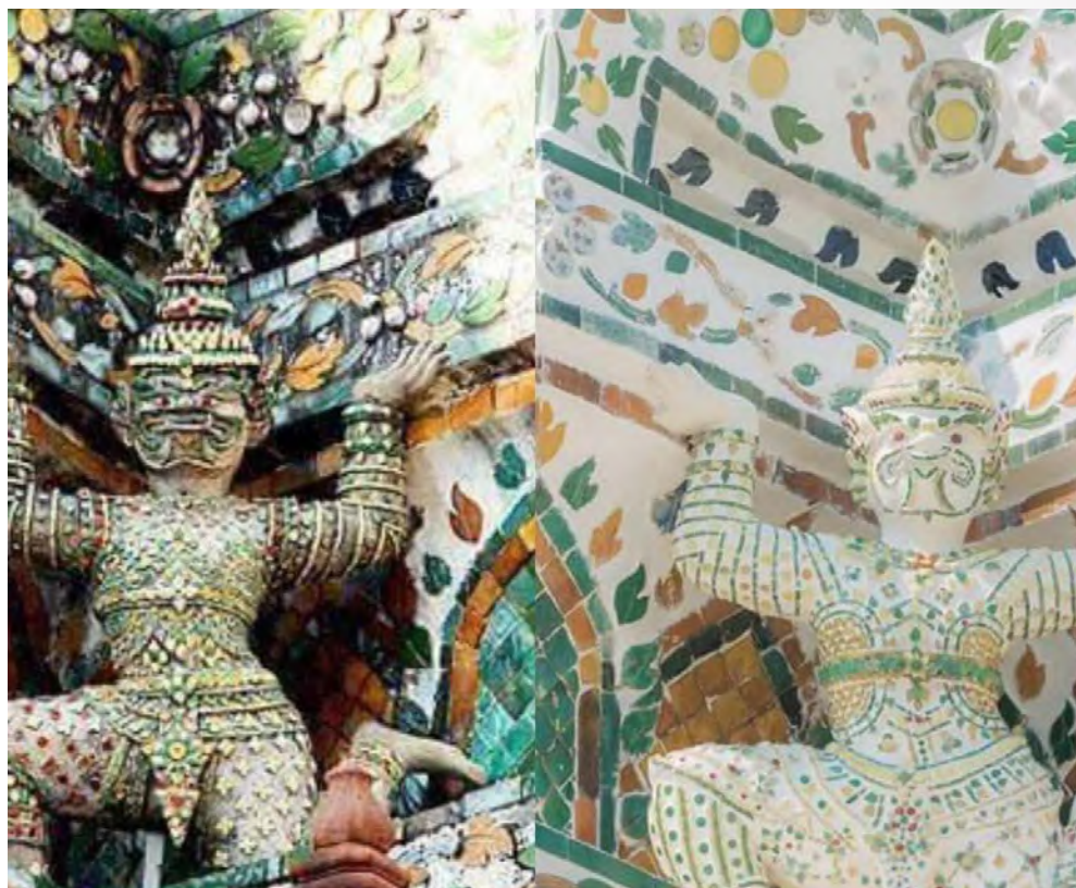
ภาพเปรียบเทียบระหว่างประติมากรรมและลวดบัวที่ฐานพระปรางค์วัดอรุณ ก่อนและหลังการบูรณะ Comparison between the old ceramic-decorated sculpture and surface before and after restoration, Wat Arunratchawaram.
