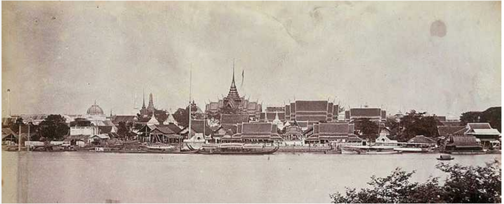
พระบรมมหาราชวังราว พ.ศ. ๒๔๑๘-๒๔๒๐ ถ่ายโดยช่างภาพชาวอิตาลีชื่อ Odoardo Beccari (๑๘๔๓-๑๙๒๐) สิงคโปร์ที่เมืองจันทบุรี กำลังก่อสร้างถึงผนังชั้นสามเพื่อบังหลังคาโดย อย่างไรก็ตามต่อมาหลังคาได้ถูกเปลี่ยนเป็นยอดปราสาท ๓ องค์ที่เชื่อมต่อกันด้วยหลังคาอนุกระสันแทน
