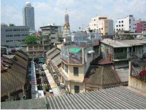
อาคารในชุมชนเลื่อนฤทธิ์ก่อนการบูรณะ Buildings in Luean Rit community before restoration.
