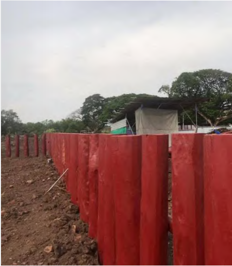
การบูรณะ-ครึ่งปีปัจจุบัน แสดงรั้วด้านนอกเป็นเสาขงหัวตัด The present restoration of the outer ring of fence with flat-topped log fence.
