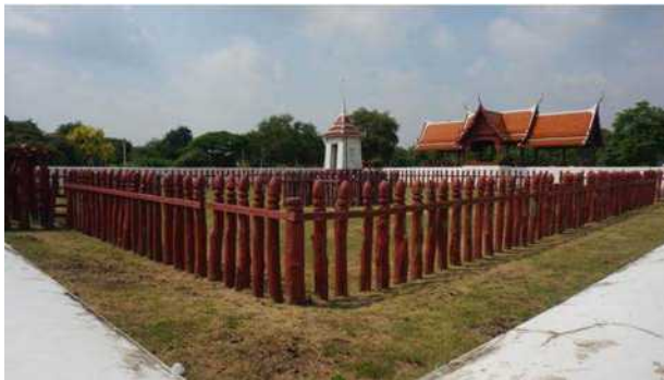
เพนียดคล้องช้างก่อนการบูรณะ แสดงวิธีเพนียดหัว เบ็ดที่เป็นผลจากการบูรณะผิดในยุکت่อน Elephant corral before restoration, showing the lotus-bud topped log fence resulted from incorrect restoration in former time.
