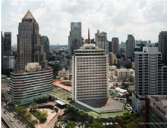
โรงแรมดุสิตธานีก่อนการรื้อถอน Dusit Thani Hotel before demolition.
