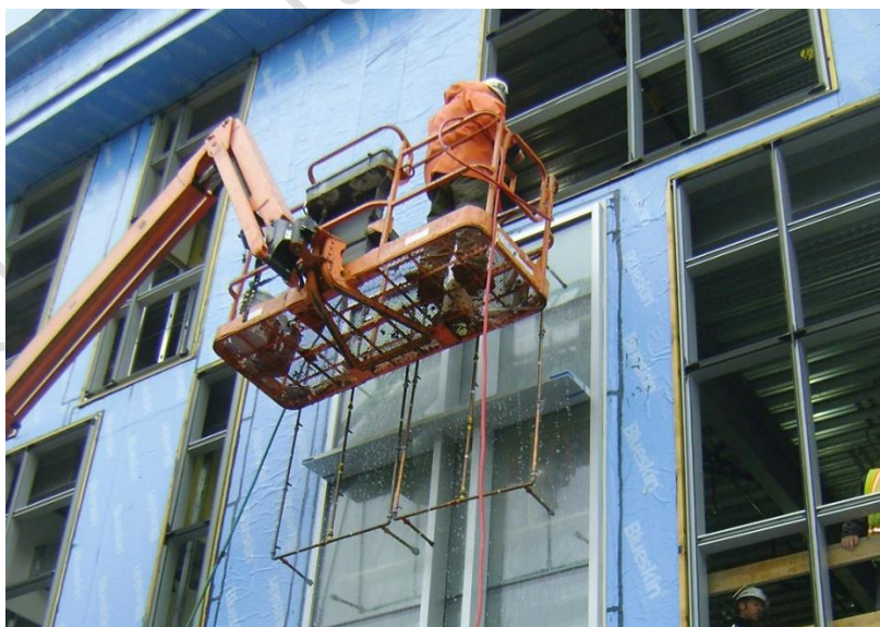
รูปที่ EE6 P1 ตัวอย่างการทดสอบการรั่วซึมของน้ำผ่านทางหน้าต่างที่ติดตั้งแล้ว ก่อนการติดตั้งวัสดุหุ้มผนัง (cladding) ที่อยู่ติดกัน
