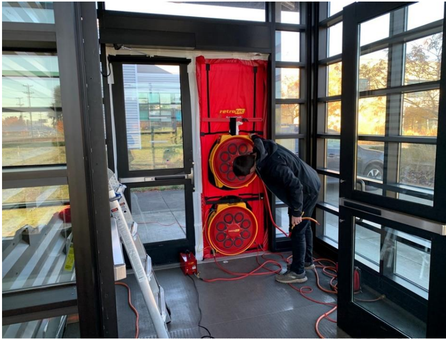
รูปที่ EE6 P2 ตัวอย่างการทดสอบการรั่วซึมของอากาศผ่านเปลือกอาคารตามมาตรฐานที่กำหนด โดยใช้ Blower Door ที่มา: https://www.airbarrier.org/education/abaa-blower-door-technician-training/
