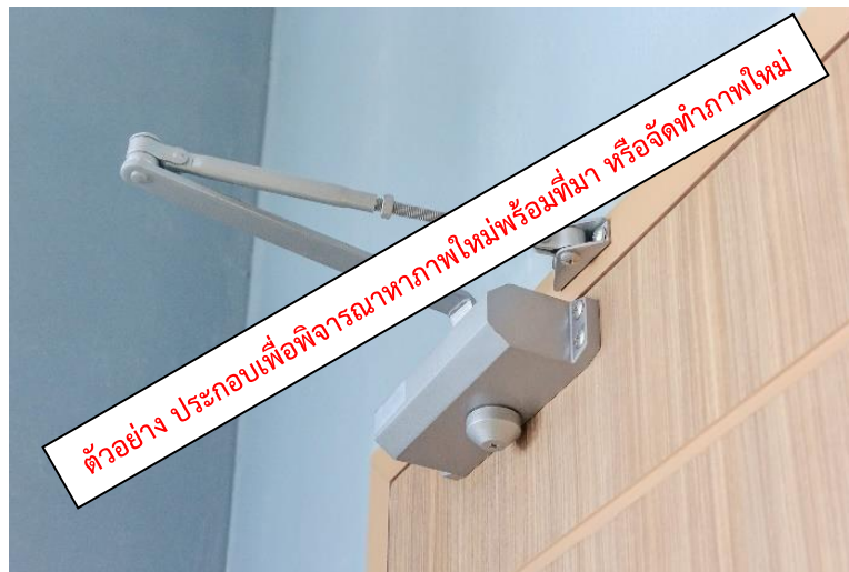
รูปที่ EE2 P2 ตัวอย่างอุปกรณ์ช่วยปิดประตู (Self-closing Door)
